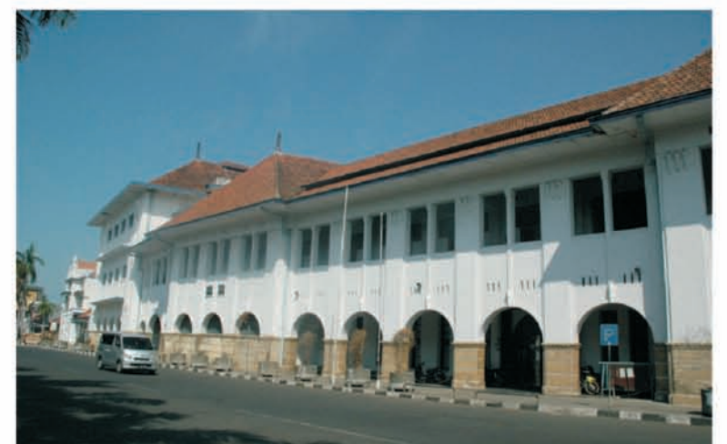
Arsitektur bangunan kolonial di Kota Cirebon.
